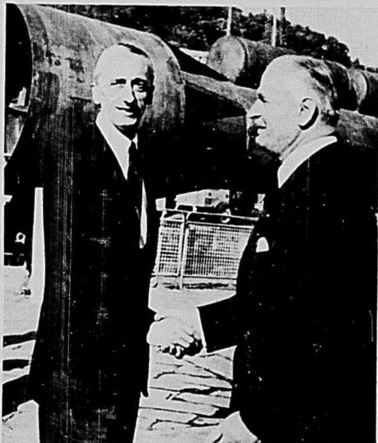
Visite de M. Palewski, haut fonctionnaire français, (le 14 octobre) aux chantiers de construction que lui fit alors visiter le Commandant Cousteau. Au second plan, les éléments en cours de montage.
