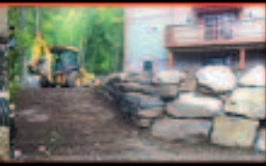
MUR DE PIERRE
