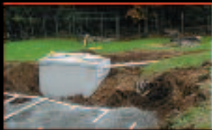
INSTALLATION DE FOSSE SEPTIQUE
