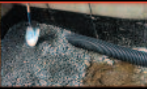
RÉPARATION DE DRAIN FRANÇAIS
