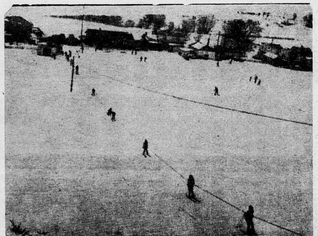
Vue d'un des deux monte-pentes d'une capacité de plus de 1200 skieurs à l'heure.
