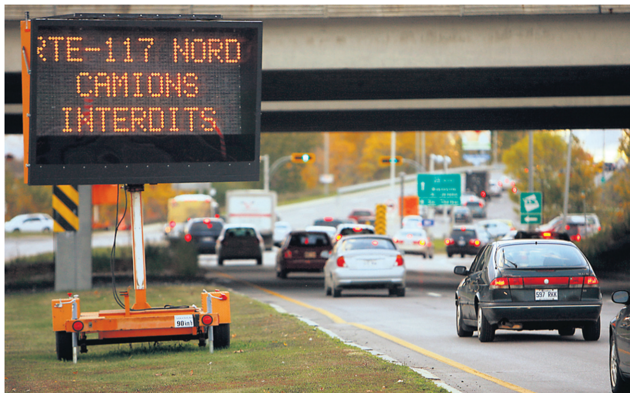
Le pont de la route 117 qui enjambe une voie ferrée au nord de la 640 est dans un très mauvais état, ce qui force le ministère des Transports à y réduire le trafic.
