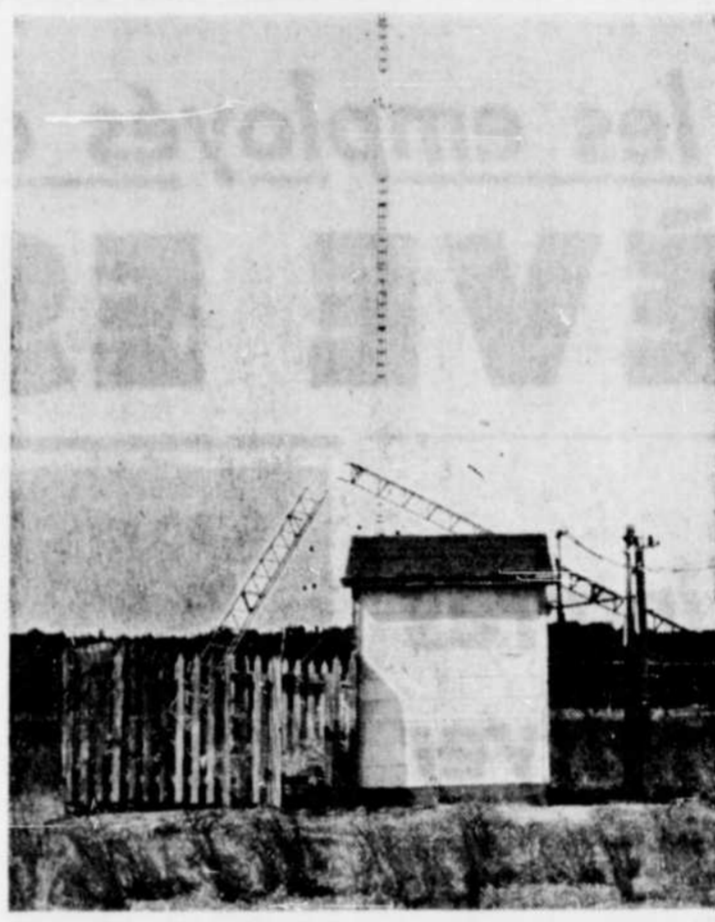
Voici dans quel état deux débardeurs de Québec auraient laissé une des trois tours de transmission du poste de radio CKCV. La tour mesurait 185 pieds. Les pertes seraient de l'ordre de plus de $25,000.
