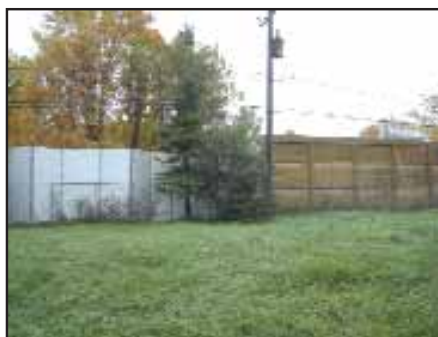
Figure 1 : Murs antibruit construits par des résidents le long d'une autoroute.
