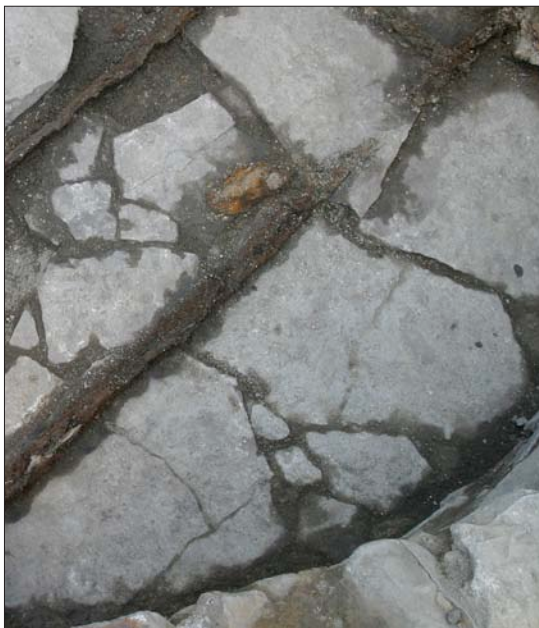
Photo 2.5 Dallage du plancher du moulin de François Charon
