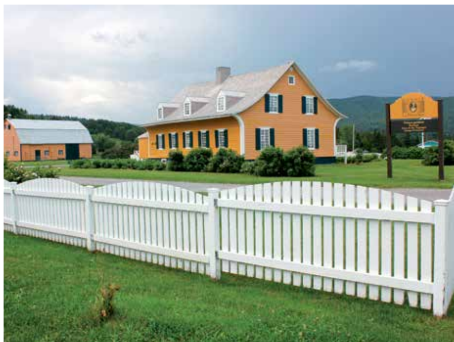
↑ Le manoir Le Boutillier, à Gaspé. Malgré certaines contraintes, il est plus simple de sauvegarder des constructions de ce genre que des quais et des phares, selon le maire Daniel Côté.
