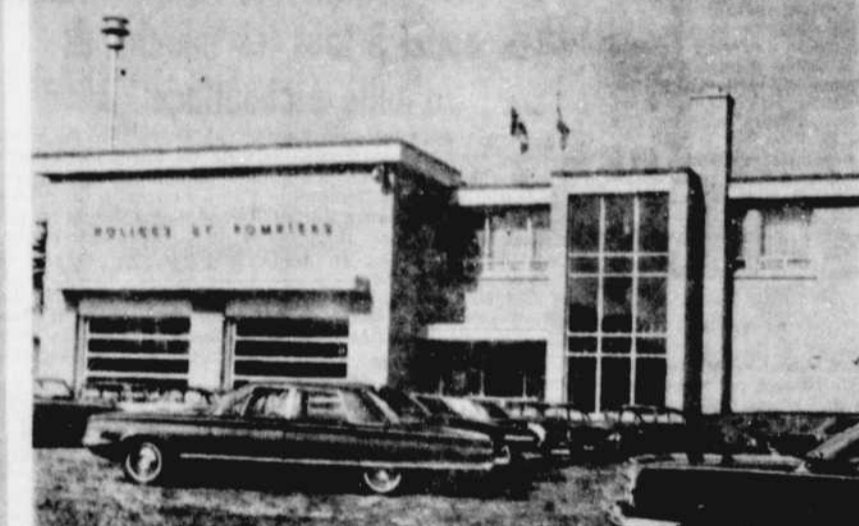
MAGNIFIQUE COUP D'OEIL — La façade principale du nouvel hôtel de ville de Coleraine suscite l'admiration tant des visiteurs que des citoyens, par ses lignes modernes et harmonieuses. La photo ci-haut illustre la façade principale, laquelle donne sur la route No 1. (Photo La Tribune, Thetford Mines)
