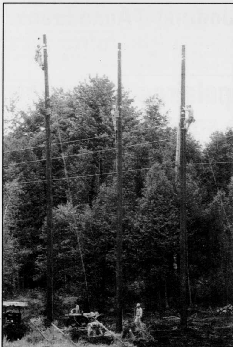
Des travaux sont en cours au poste Cleveland, à Granby, en complément du vaste chantier qui anime la région. photo Alain Dion
