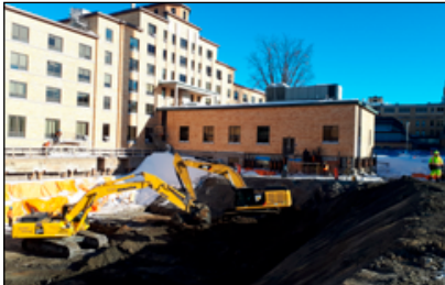
Représentant un grand défi logistique, les travaux pour le bâtiment des génératrices ont cours derrière l'aile H.
