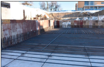
Le CIC : une infrastructure de pointe construite sur des bases solides. Photo : Pomerleau.
