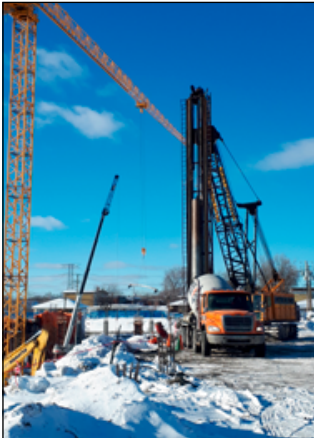
Les machines servant à enfoncer les pieux pour les fondations du CIC viendront faire un dernier tour de piste en mars.
