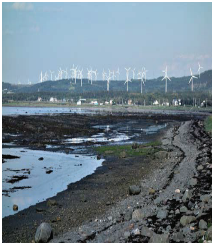
Parc des éoliennes, à Cap-Chat
