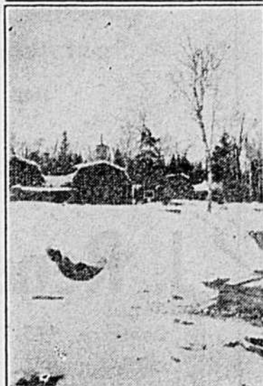
Souvenir de l'hiver au chantier coopératif de Roquemaure.
