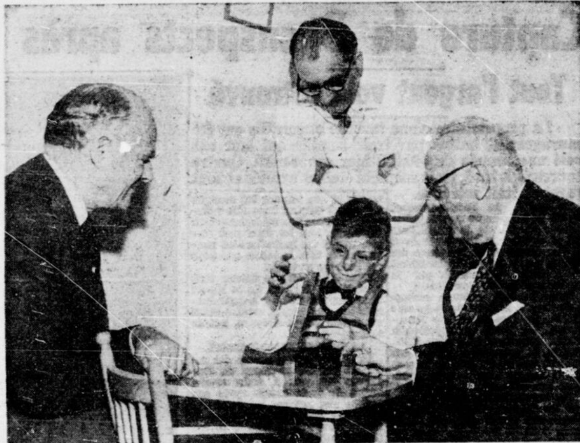
LE CENTRE DE L'INSTITUT DE REHABILITATION DE MONTREAL vient de lancer un appel au public. La campagne, qui durera jusqu'au 15 février, vaudra recueillir $3.100.000 pour la construction d'un nouveau centre de réhabilitation dans la métropole. Cette photo nous fait voir un des petits patients de l'Institut, sous la surveillance d'un médecin spécialiste en thérapie "occupationnelle". A gauche, le brigadier John-H. Price, OBE, MC, président de la campagne de souscription, et, à droite, le Dr Frank Krusen, directeur de la section de médecine physique et de réhabilitation de la clinique Mayo, à Rochester.
