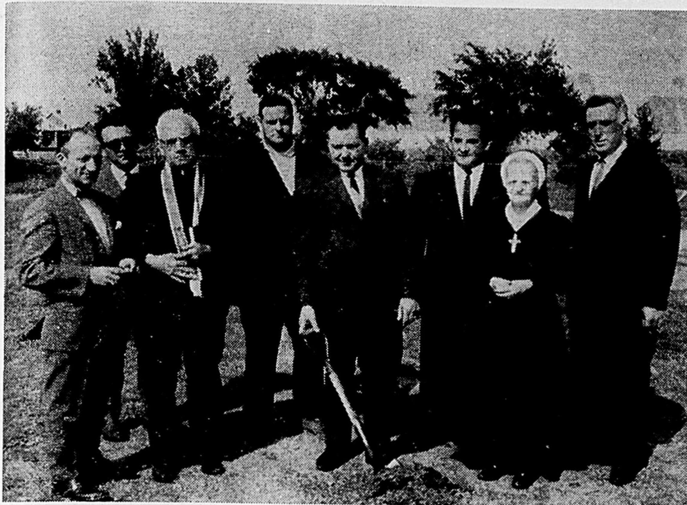
M. Champlain Grégoire, président de la Commission scolaire de St-Paul, lève la première pelletée de terre, sur le site du chantier de l'agrandissement de l'École Notre-Dame du Sacré-Coeur. Dans l'ordre: M. Gérard Forest, secrétaire, M. Jean Dubeau, architecte, M. l'abbé Gé-
