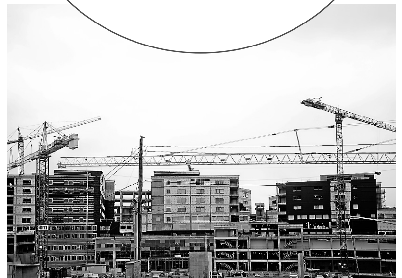
PHOTO MARCO CAMPANOZZI, LA PRESSE Le chantier du CUSM à la fin du mois de septembre.
