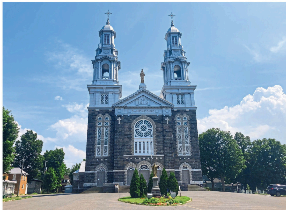
L'un des clochers de l'église de Sainte-Hénédine a besoin de réparations pressantes.
