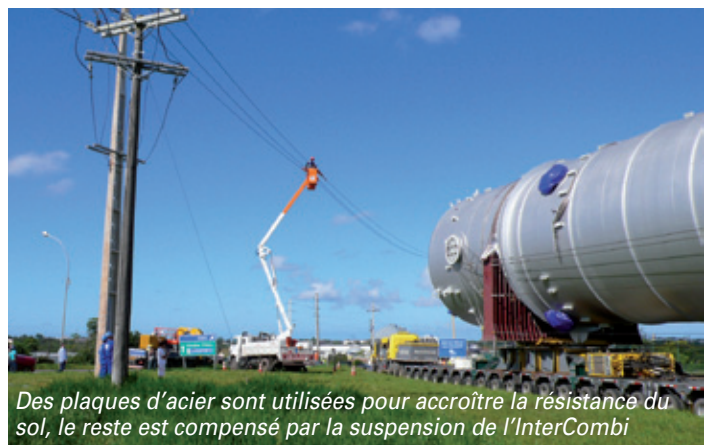
Des lignes électriques et des portiques de signalisation ont dû être soulevés pour permettre au convoi de passer.
