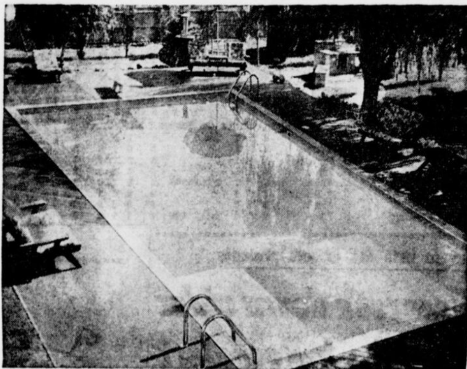
Piscines TROJAN tout aluminium manufacturées au Canada selon les mêmes spécifications que celle ci-dessus, qui a remporté le prix national des États-Unis pour son excellente structure.
