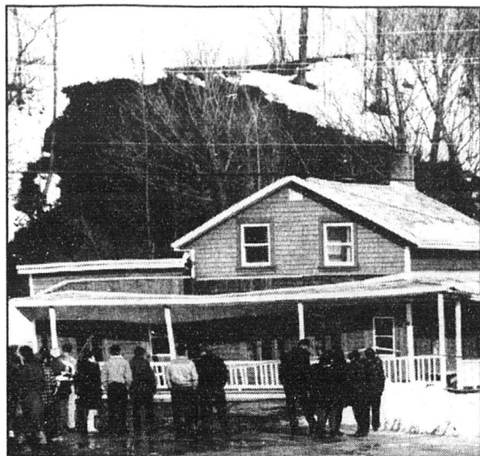
Un glissement de terrain a emporté cette maison qui s'est finalement retrouvée en pleine rue, hier matin, à Château-Richer, en banlieue de Québec.
