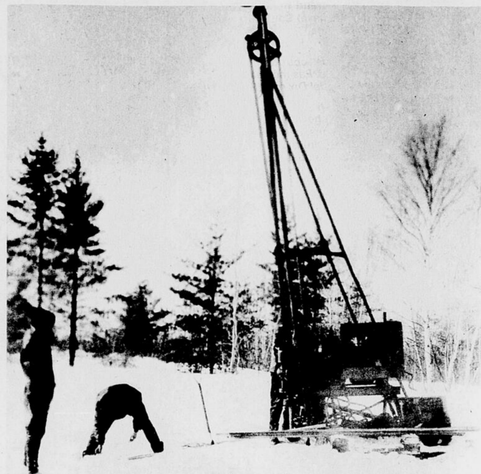
A SEPT MILLES DE SAINT-FELICIEN — Les travaux de sondage de sol commandés par Donohue, sont effectués à sept milles environ de Saint-Félicien et à deux milles et demi de la Chute à l'Ours de Normandin. Ils durent depuis le 25 juillet dernier.
