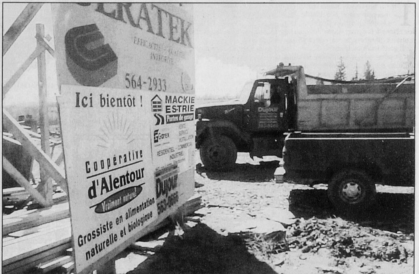
Les travaux de construction du magasin entrepôt de la Coopérative d'Alentour, situé sur la route 220, seront terminés en juillet prochain.
