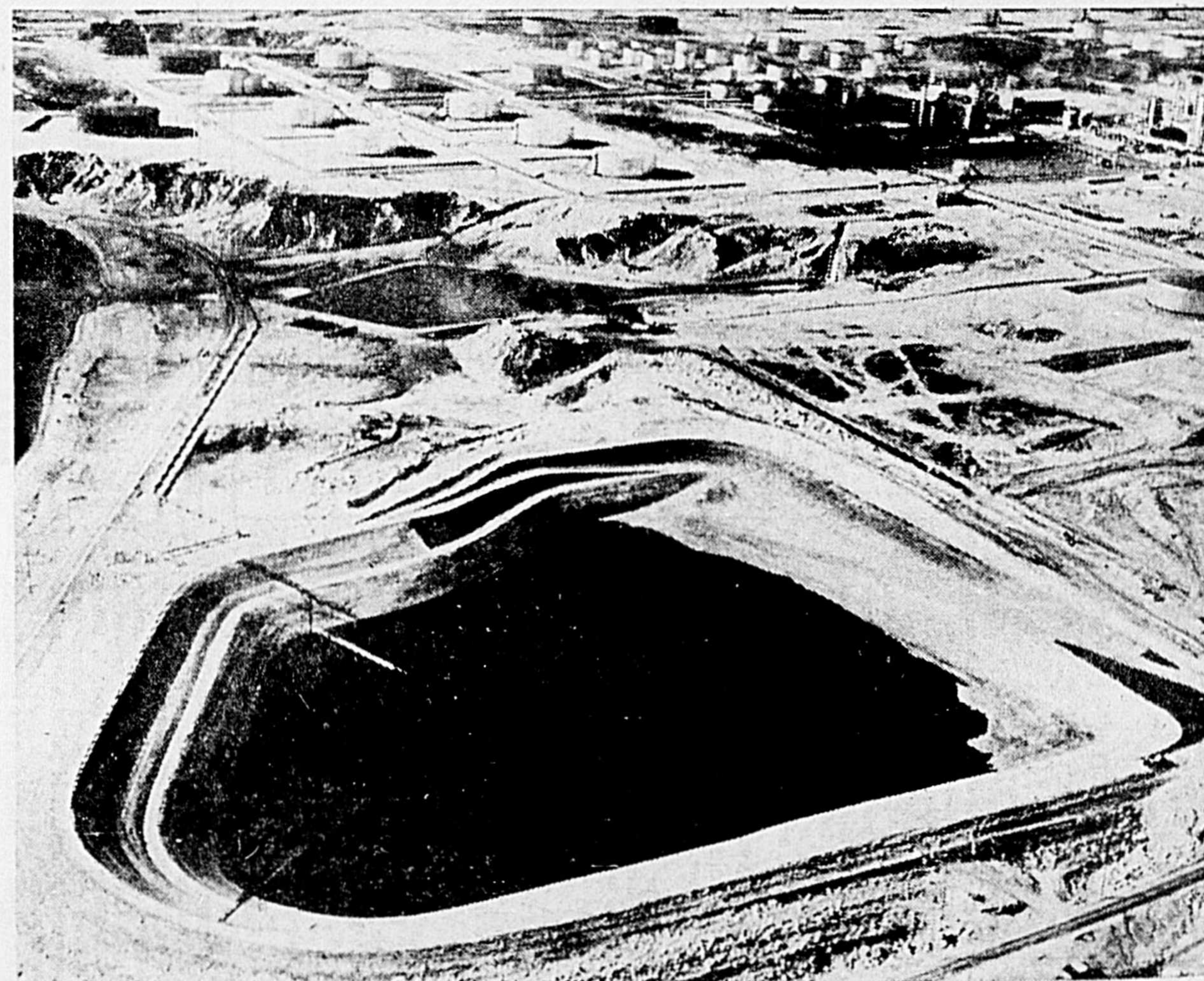
Puits d'huile à ciel ouvert à Amuay. La compagnie Créole en a deux de ce genre contenant 12,300,000 barils. Ces puits servent d'entrepôts, remplis en été en prévision du reste de l'année.
