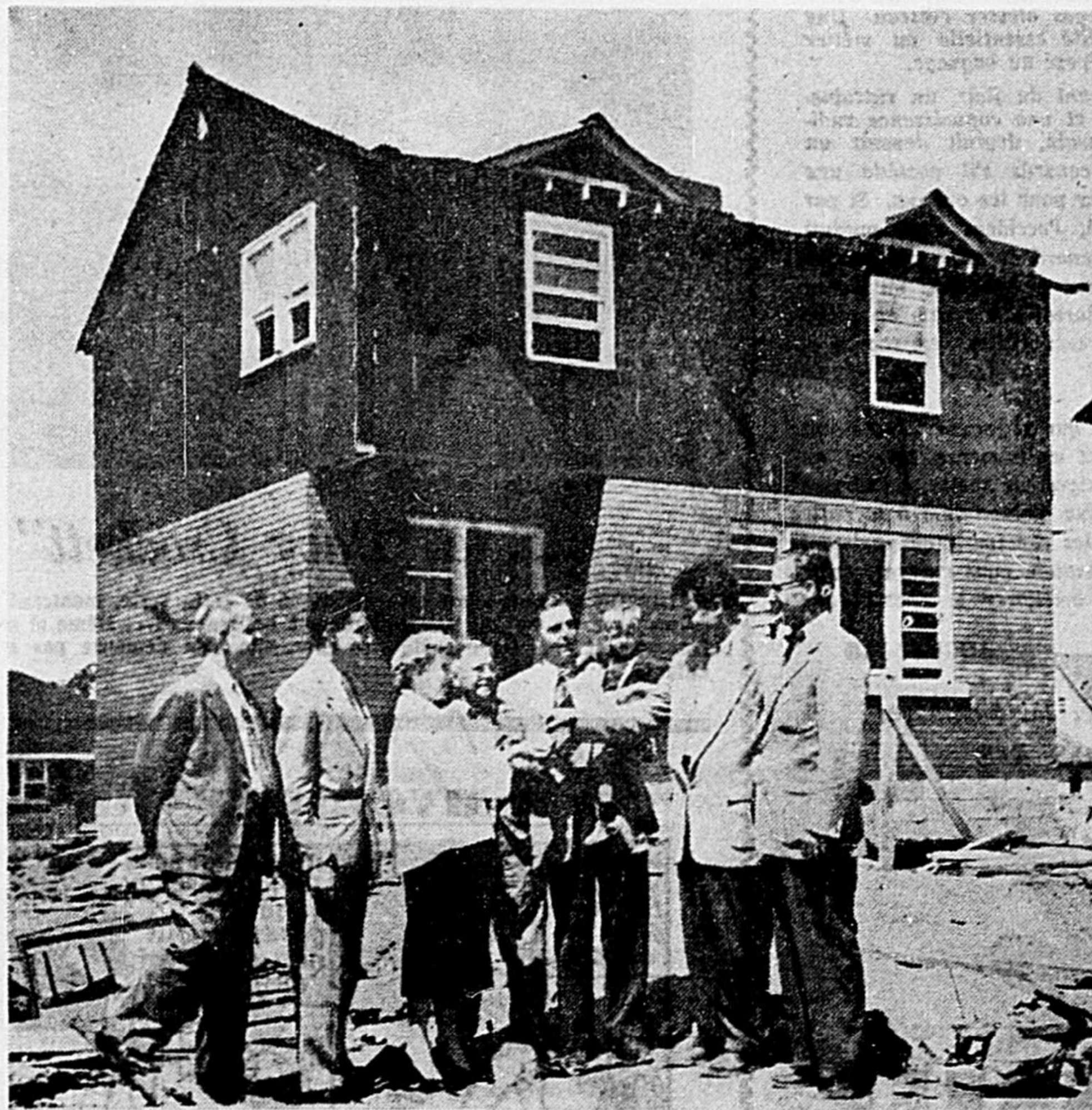
La compagnie de construction Campeau, à Ottawa, qui terminait sa 1,000 e maison en 1954, compte à la fin de 1956 un total de plus de 2,300 maisons unifamiliales, 80 maisons de rapport comprenant 600 logis et un édifice de neuf étages de 80 logis. Dans la photo nous remarquons une des heureuses familles qui devinrent propriétaires. La compagnie Campeau vient de lancer un projet de construction de $60,000,000.
