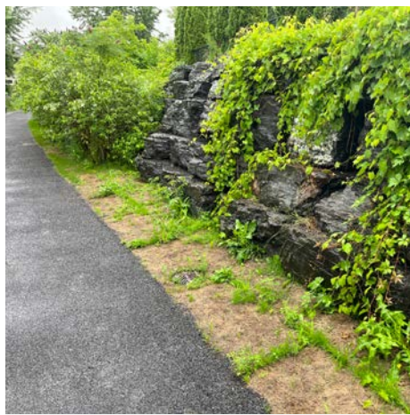
Plus loin sur le sentier, les murs de soutènement sont adossés aux propriétés et le sentier est environ deux mètres plus bas que celles-ci.
