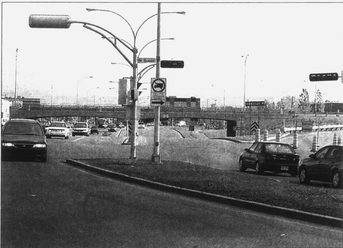
L'intersection du boulevard du Séminaire et de la rue MacDonald sera revue et corrigée pour permettre l'accès en tout temps au pont Marchand.
