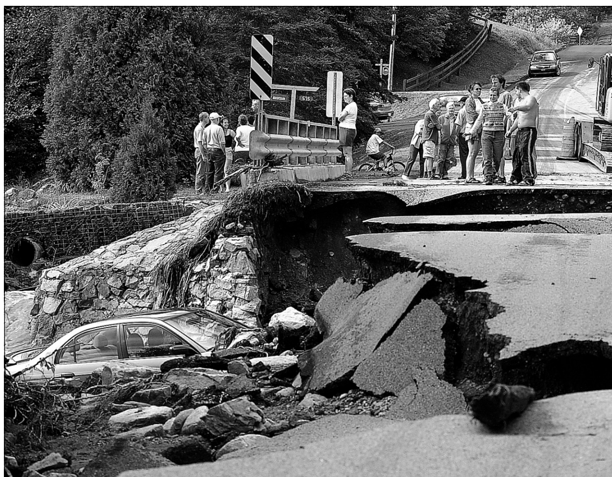
Dans Charlevoix aussi, les éboulements ont laissé des marques sur le réseau routier.
