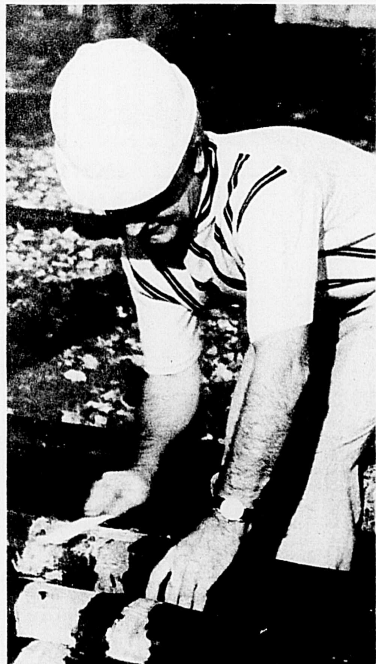
Le joint fait entre deux parties de conduit est sablé de façon à permettre l'application d'un second "pansement".
