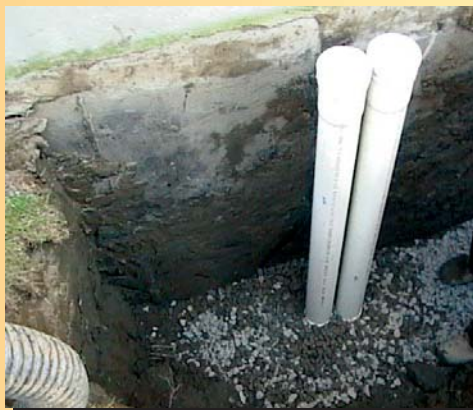
Installation type de cheminées de nettoyage
