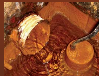
Dépôt de boue gluante de couleur ocre dans le bassin de captation des eaux pluviales
