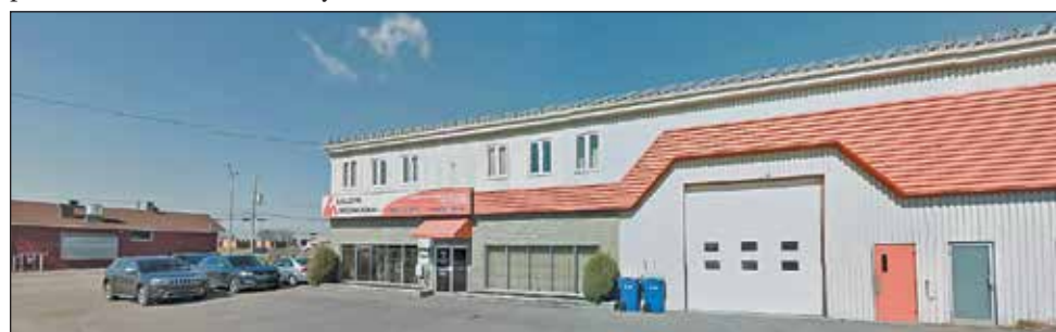
Guillevin International, spécialisé en approvisionnement et distribution de produits électriques, est situé dans le parc d'affaires Arthur-Miron.
