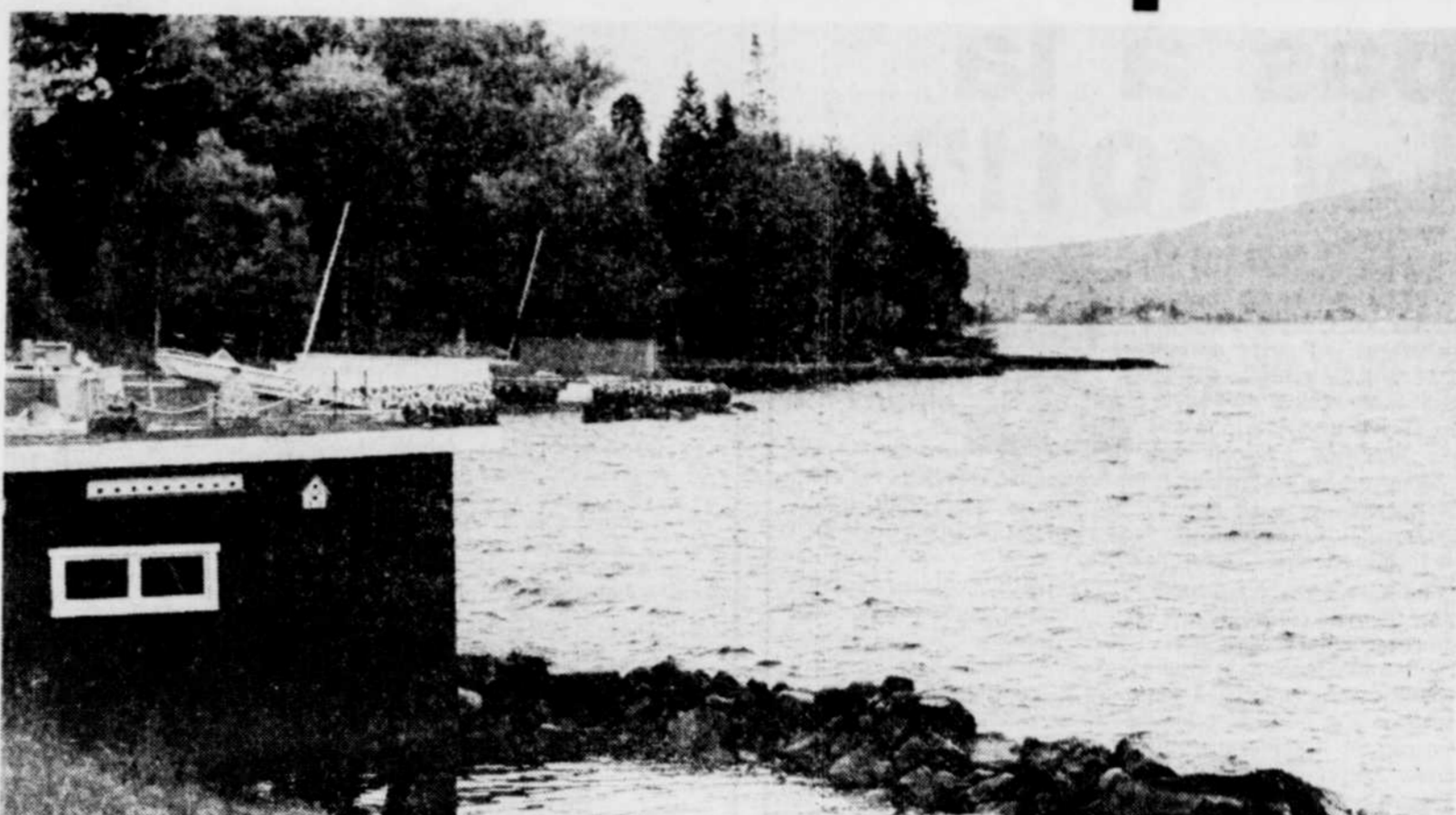
Les propriétaires de chalets du lac Saint-Joseph ont eux-mêmes contribué et contribuent encore largement à la détérioration du milieu: déboisement des rives, empiètements sur le littoral, endiguements, construction d'ouvrages en béton, quais ou murs de soutènement, etc. Et ce ne sont là que quelques exemples.
