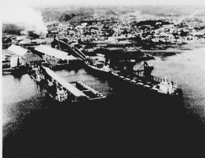
TRAVAUX — C'est à proximité de ses installations portuaires à Ville de La Baie que la société Alcan veut entreprendre des travaux de réaménagement de l'embouchure de la Rivière-à-Mars.
