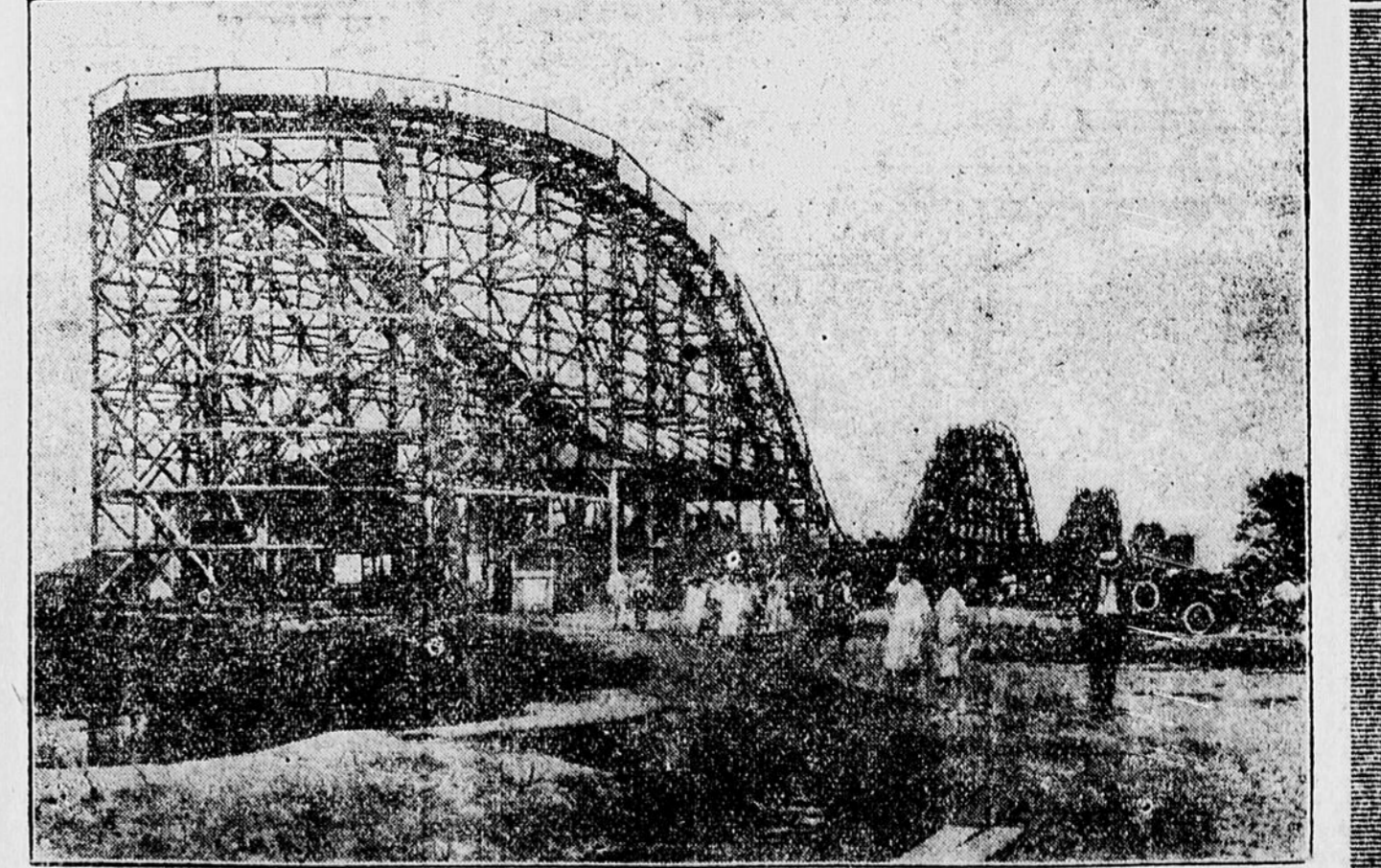
Nos Nouvelles Montagnes Russes de 1925 en voie de construction au Luna Park, à Hull. On les considère les plus grandes et les plus émoionnantes au Canada.
