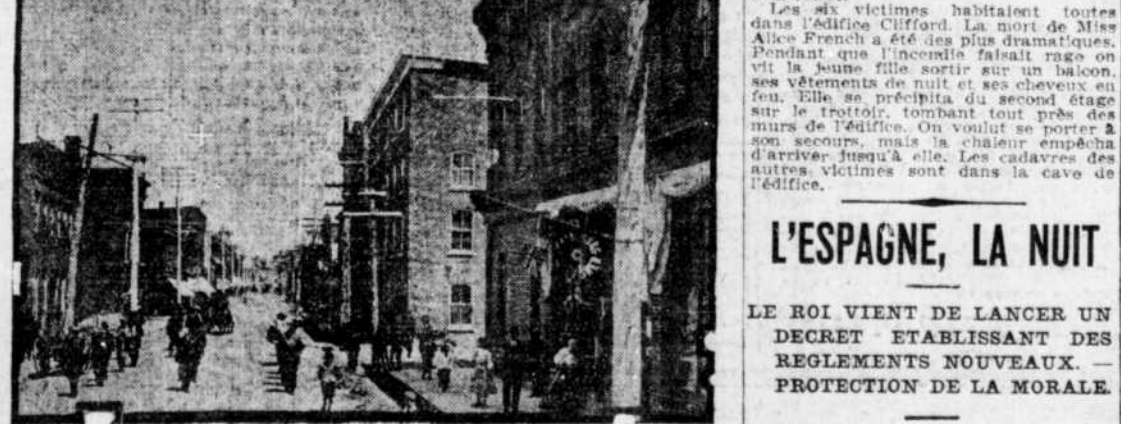
La rue principale de Pembroke, qui vient d'être ravagée de nouveau par un violent incendie, hier matin. — La croix indique l'édifice qui récemment a été détruit.
