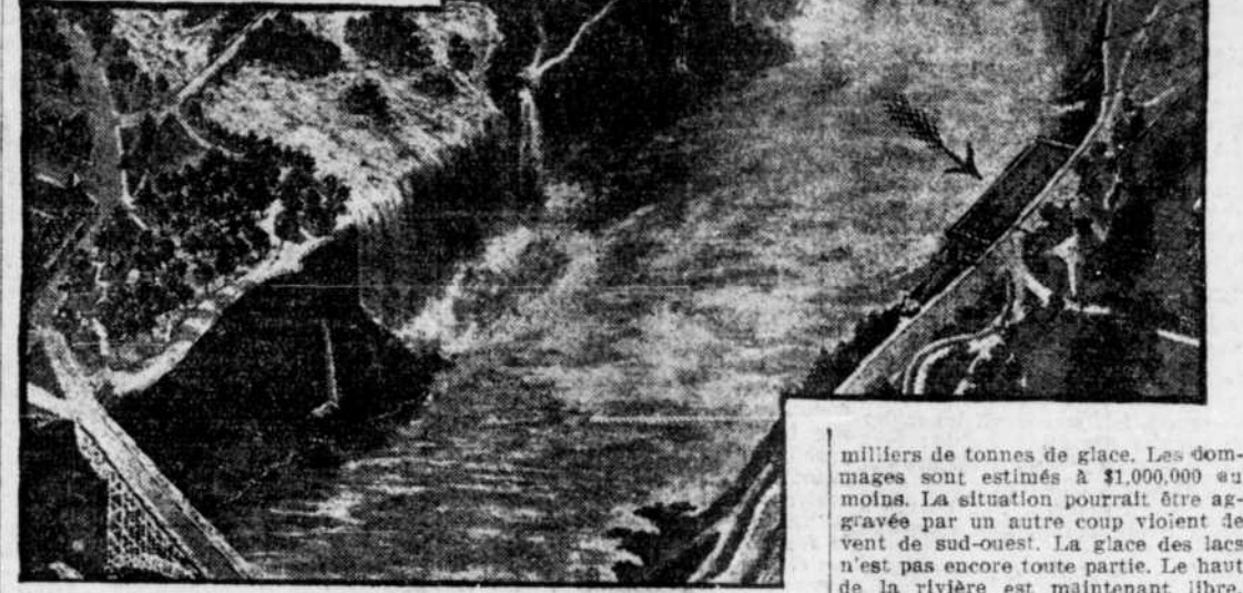
Le débordement du Niagara. — La flèche indique l'usine d'énergie de la "Ontario Electric Company", construite à quarante pieds au-dessus du niveau ordinaire de l'eau, au pied des chutes. Les machines de cette usine sont inondées.
