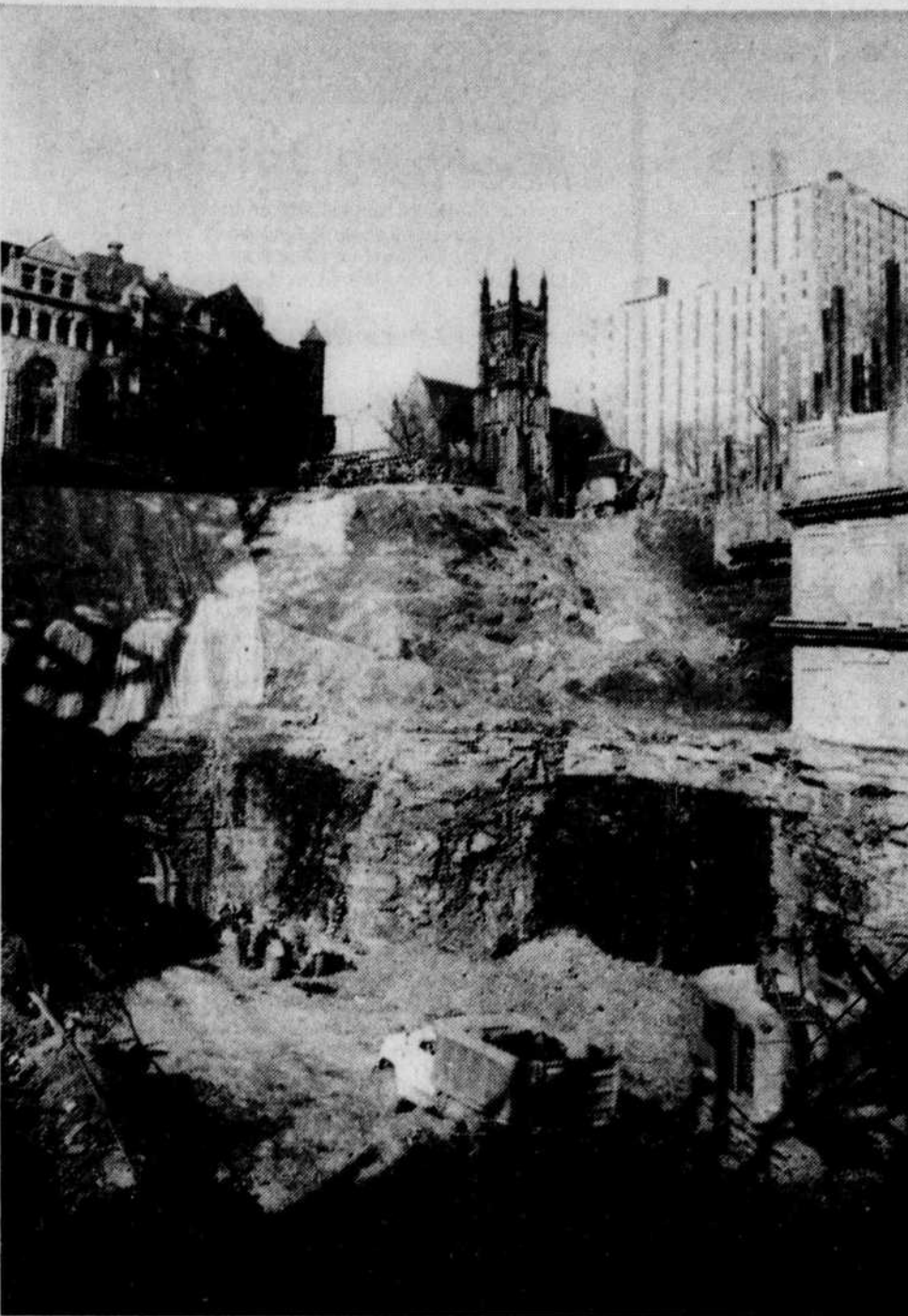
Les travaux progressent normalement à la dernière excavation importante du métro au cœur de Montréal. Spino Construction Company Limited, entrepreneurs de cette section du métro, qui comprend le complexe de la Place Victoria-Place Bonaventure et un tunnel de 6.000 pieds, utilisent des techniques de sautage rigoureusement contrôlées et de lourdes nattes de sautage. Des lectures sismographiques sont effectuées régulièrement afin d'assurer que les niveaux de vibration et d'ébranlement n'excèdent pas les limites permises. Les explosifs sont expédiés par l'usine de Beloeil de Canadian Industries Limited.
