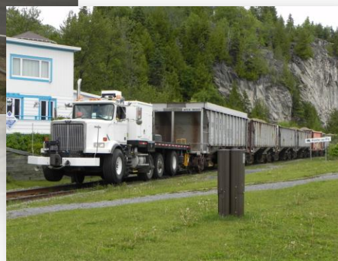
Réparation de la voie en juin 2010
