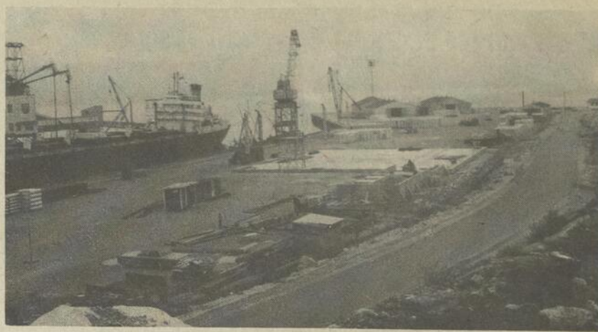
La nouvelle fondation pour recevoir l'entrepôt au quai de C.B.A.
