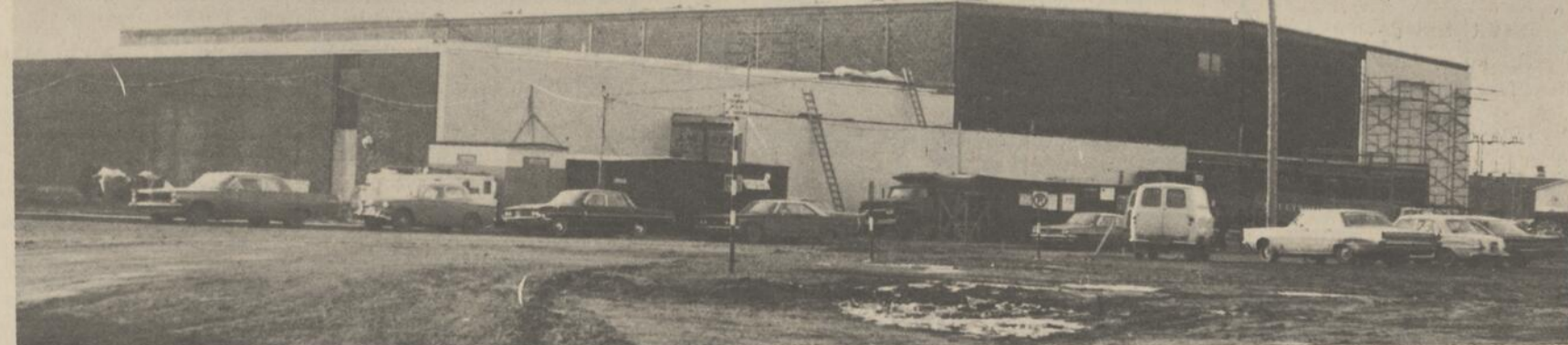
LES TRAVAUX DE CONSTRUCTION de la nouvelle aréna de Granby sont très avancés comme le laisse voir cette photo montrant l'extérieur de l'édifice. La réalisation de ce projet aura coûté plus de $850,000 à la cité de Granby une fois que tous les travaux auront été complétés, y compris l'installation des sièges. Dans l'ensemble, il s'agit d'un projet d'un peu plus d'un million de dollars si l'on tient compte du coût du terrain,
