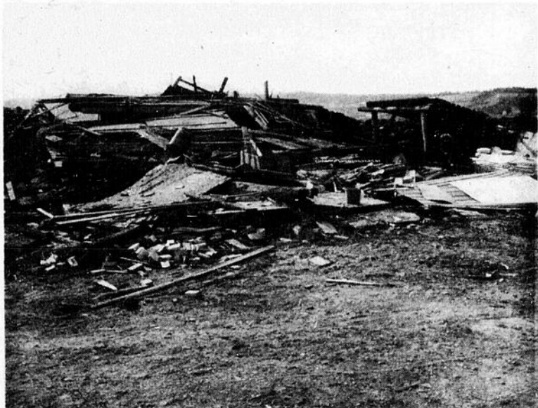
3 septembre: De fortes bourrasques causent d'importants dégâts à Frampton.
