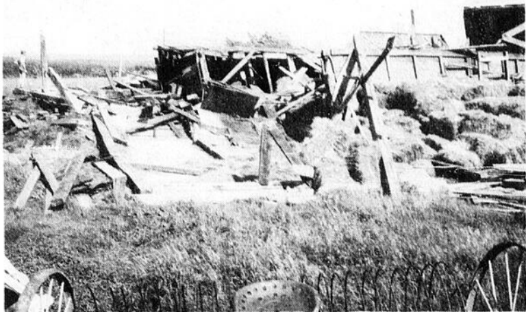
7 juillet: Une violente tornade s'abattant sur les municipalités de St-Luc, Ste-Justine et Ste-Sabine causent d'importants dégâts.
