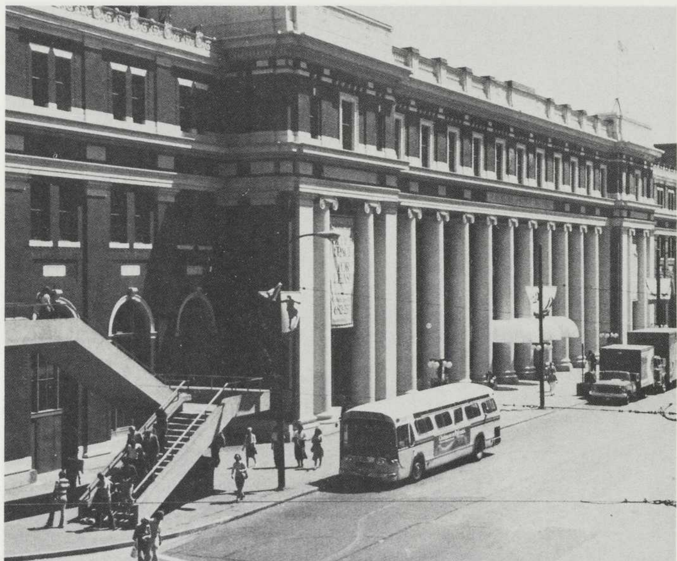
The Station...la vieille gare du Canadien Pacifique jouit d'un rôle nouveau après avoir échappé à la boule des démolisseurs.
