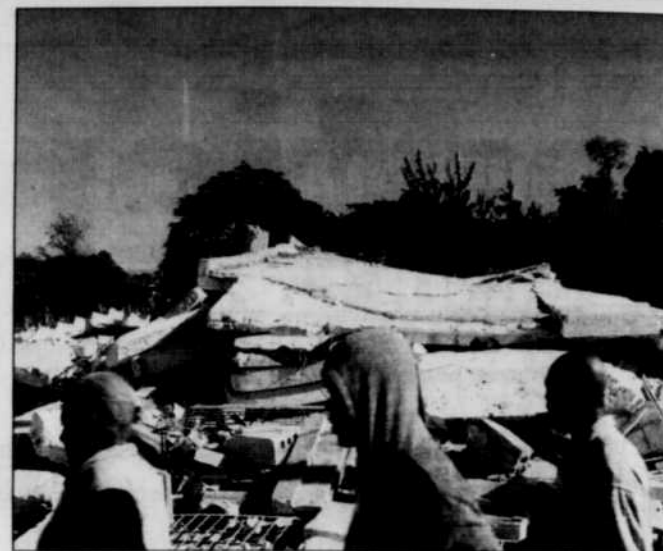
Caroline a pu prendre quelques photos avant de quitter Haïti. Tout autour de son hôtel s'est effondré.
