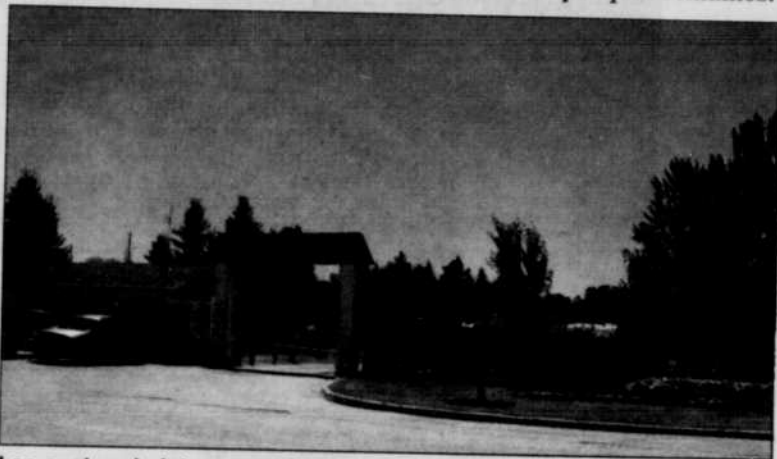
Les quatre chalets seront érigés sur les terrains du camping municipal d'Albanel. La municipalité s'attend de payer autour de 175 000 à 200 000 dollars.
