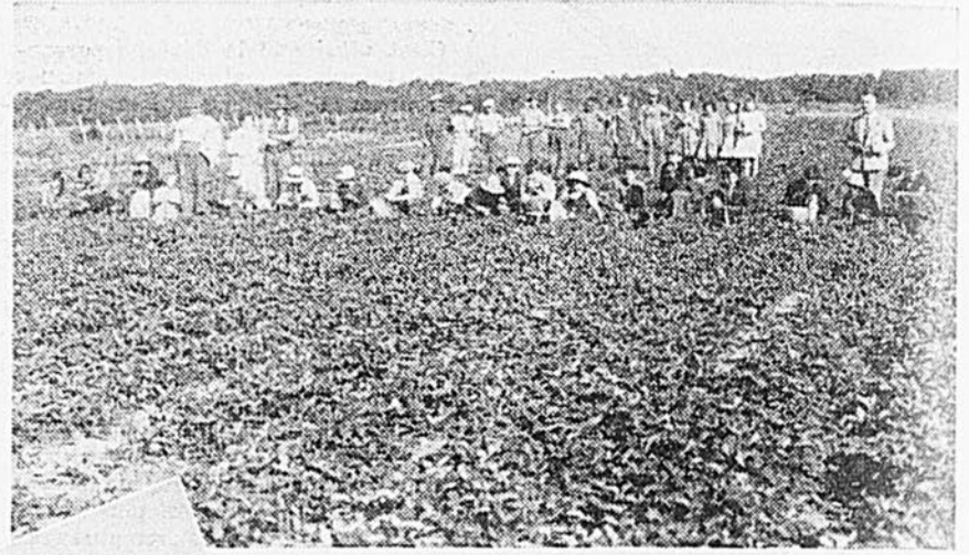
Chez les gros producteurs, la cueillette pose un problème de main d'oeuvre que souvent l'on résout en mobilisant tous les gens du canton.
