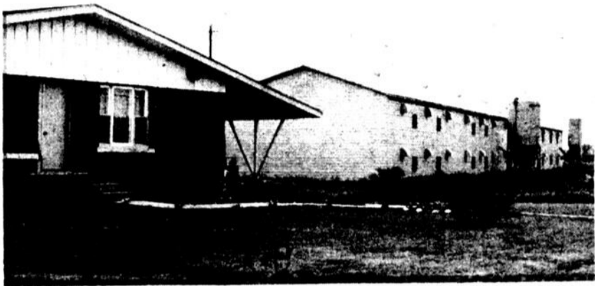
Cette photographie nous montre la nouvelle bâtisse de la Ferme Avicole Victoria de Saint-Albert, laquelle est construite tout près de la maison de M. André Lessard. Ce dernier se plaint
