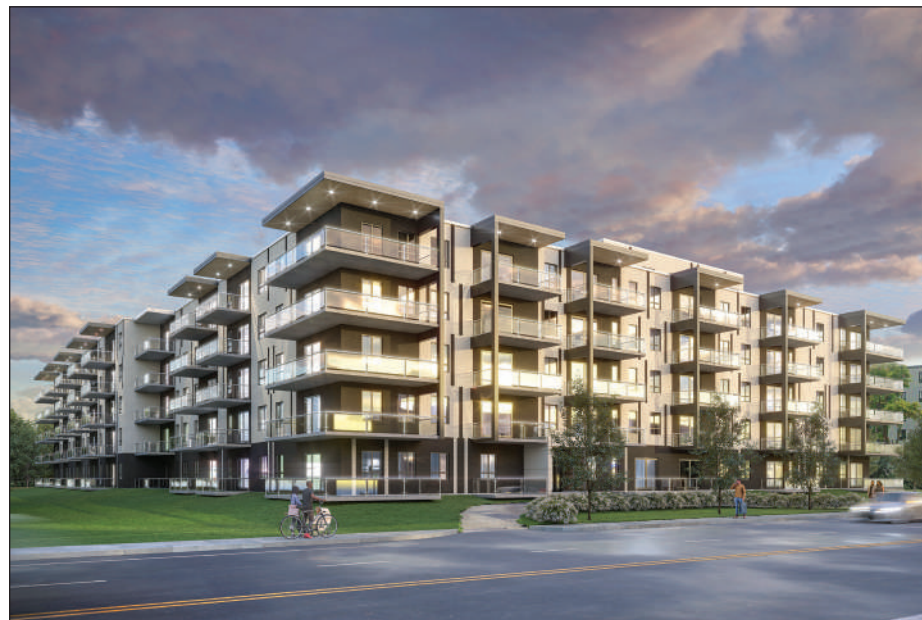
Les condos Saint-Philippe comprennent 119 unités spacieuses réparties sur 5 étages, en plus d'une série de commodités.
