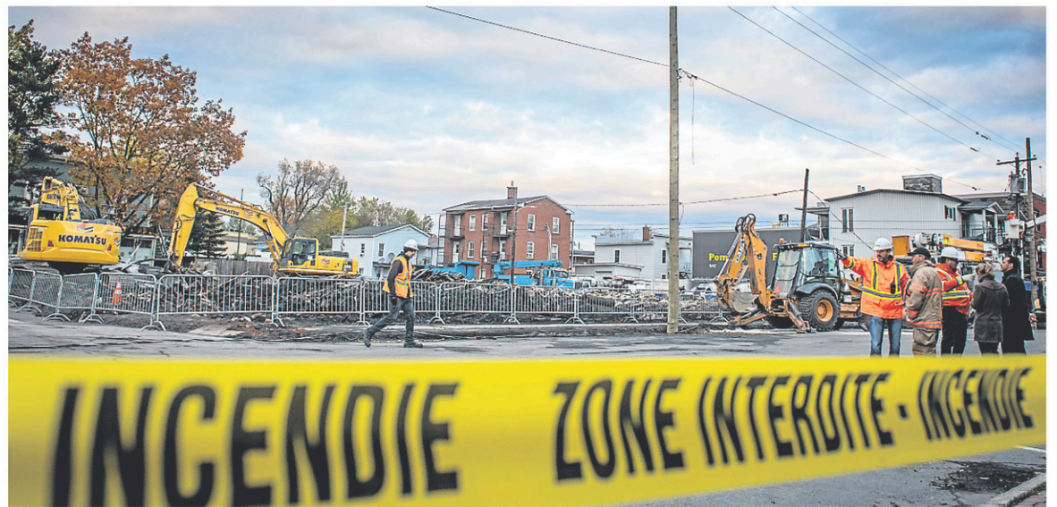
Pourquoi aucun avertisseur de fumée n'a-t-il retenti à l'apparition des flammes au 12 Deragon la nuit de lundi à mardi?
