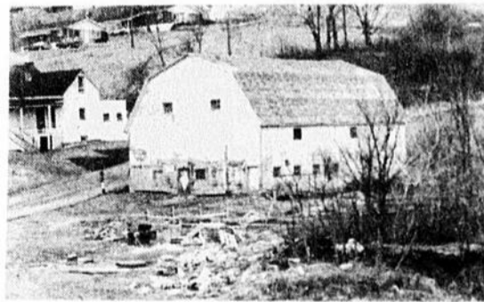
Cette grange devra être détruite ou déplacée.
