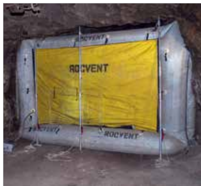
Barricade pneumatique installée
