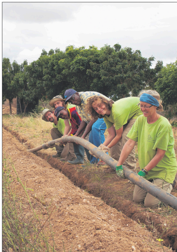
La famille a travaillé pendant deux semaines à l'enfouissement d'un tuyau pour améliorer l'irrigation d'une terre en Tanzanie.
