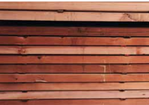
Tache de séchage sur la pruche occidentale.
