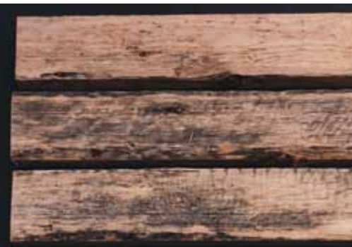
Bleuissement de surface sur le bois d'œuvre.
