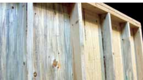
Le contreplaqué et les colombages bleuis sont acceptables en construction.
