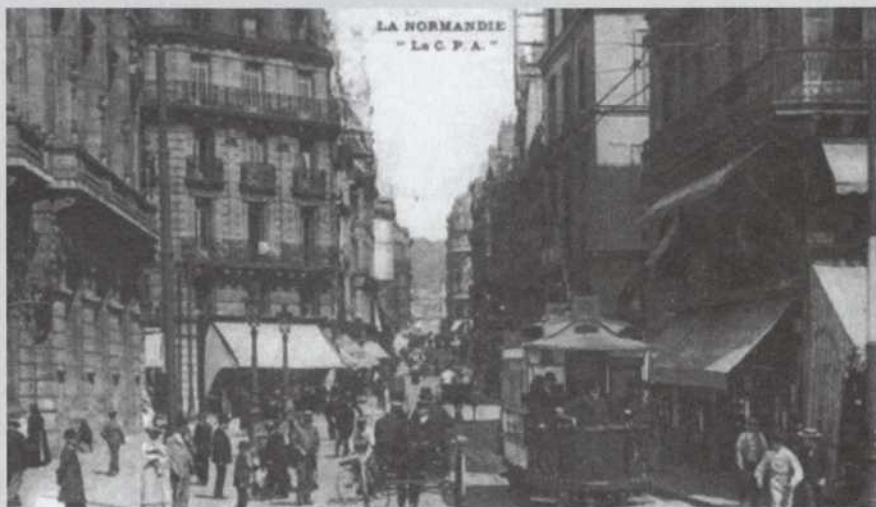
Rue du Grand-Pont à Rouen
