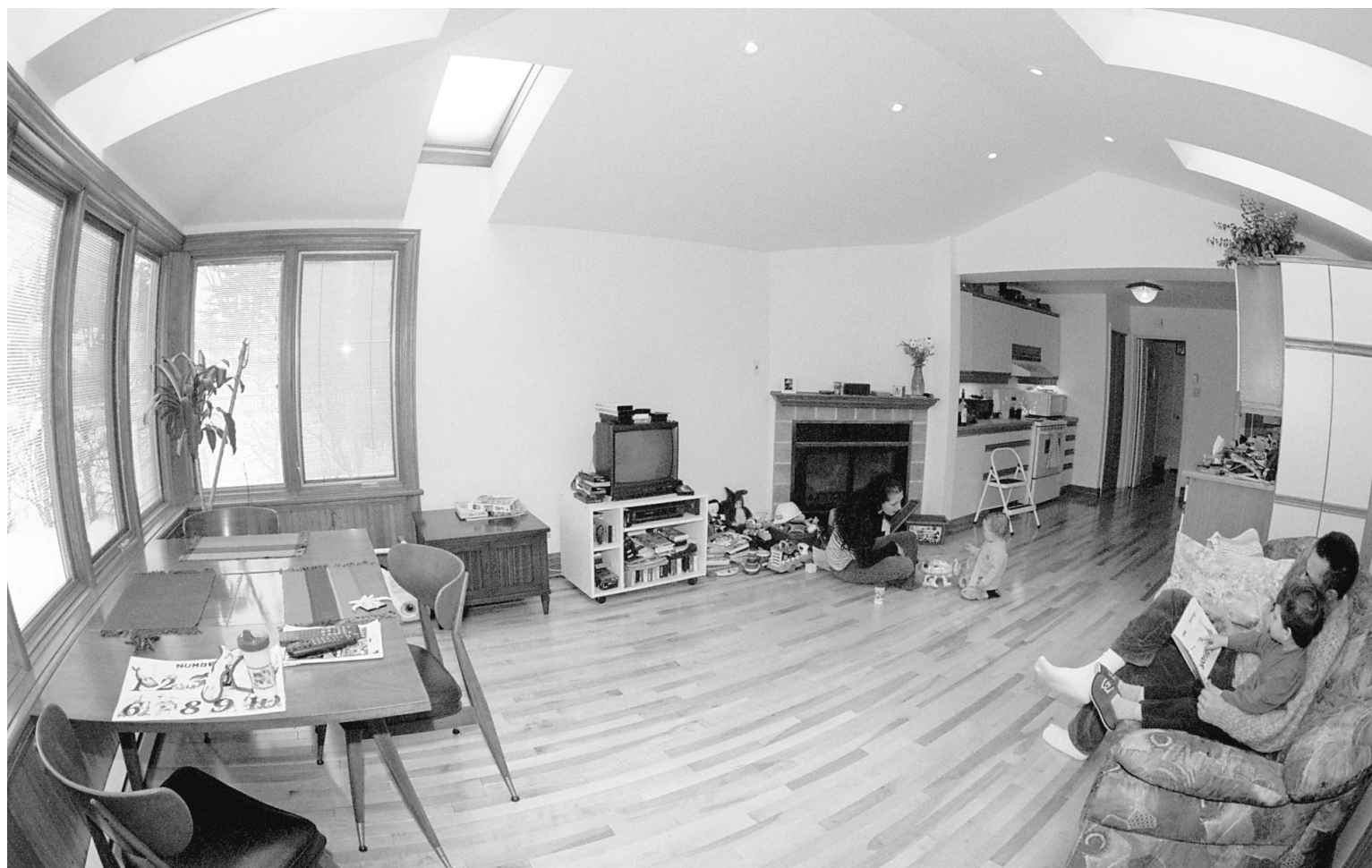
L'ancien solarium (voir page 17) a été remplacé par une pièce aussi éclairée, mais avec des murs et des plafonds bien isolés ainsi que des fenêtres étanches et des fenêtres de toit à haute efficacité énergétique.
