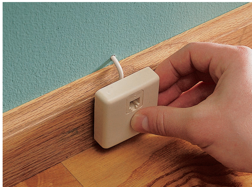
D. Vissez le bloc de raccordement au mur. Remettez le couvercle de la prise et vérifiez le fonctionnement de celle-ci.
