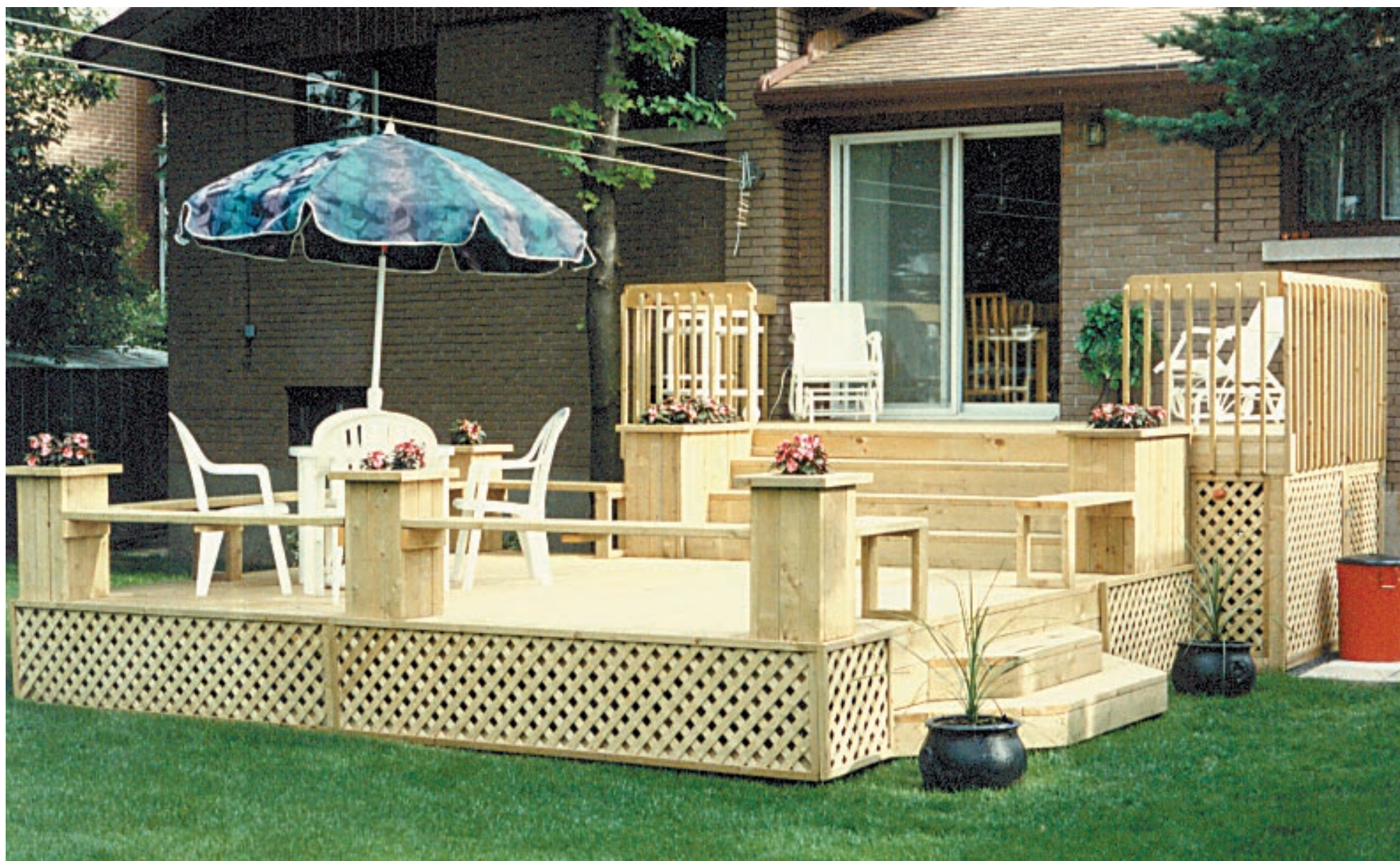
On estime chez Matco Ravary que la moitié des gens construisent leur patio eux-mêmes, économisant ainsi de 50 % à 65 % des coûts. L'apparition sur le marché d'éléments préfabriqués, notamment les marches et les tubes de béton précoülés, facilitent le travail des néophytes.
